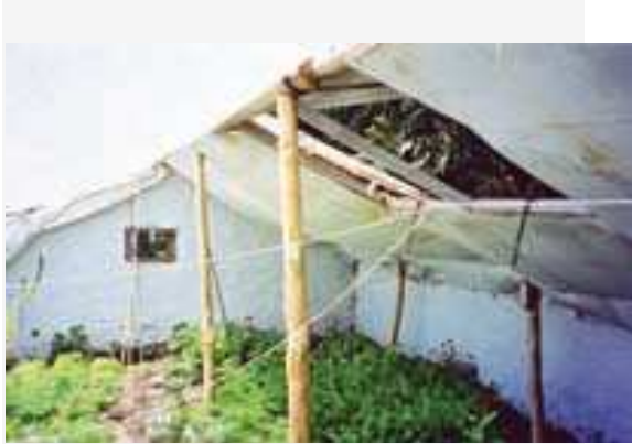
Figura 12: Vista de la cubierta desde el interior del invernadero
