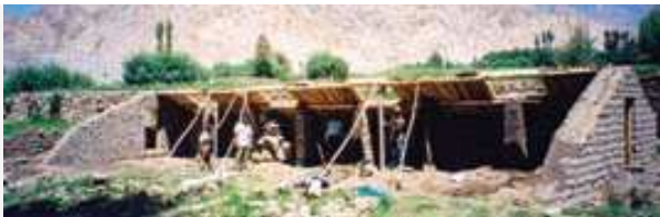
Figura 13: El Invernadero en construcción (vista de los muros dobles y la estructura de la cubierta)
