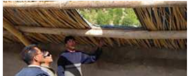
Figura 15: Apertura del ventilador de techo
