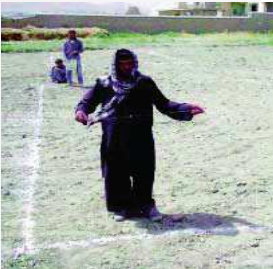
Figura 31: Marcado de la posición de las paredes
