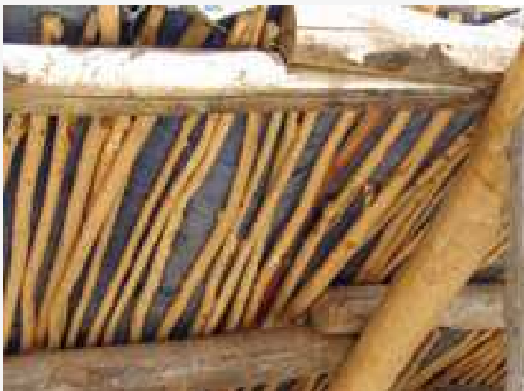
Figura 61: La capa de varillas que forman la parte inferior del techo
