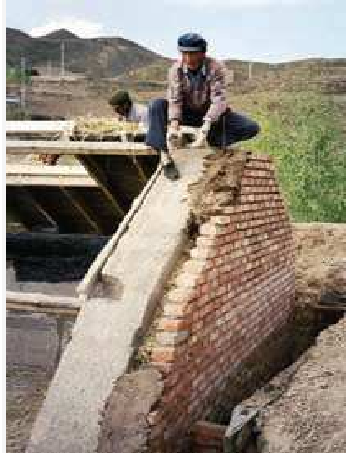
Figura 39: Construcción de una pared exterior con ladrillos cocidos y una pared interior con tierra apisonada estabilizada en Qinghai
