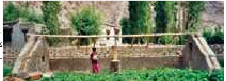
Figura 57: Techo de estructura con dos vigas y marcos del obturador en posición en Spiti
