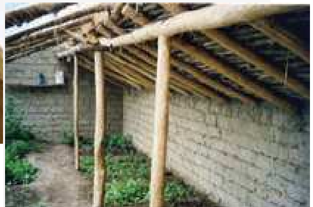
Figura 59: Vista general de la estructura del invernadero
