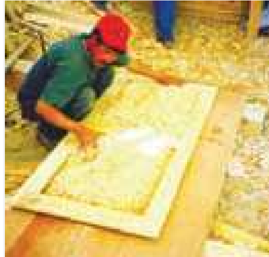
Figura 45: Montaje de la puerta
