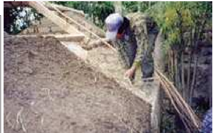
Figura 62: Aplicación de las capas de cartón, paja y barro
