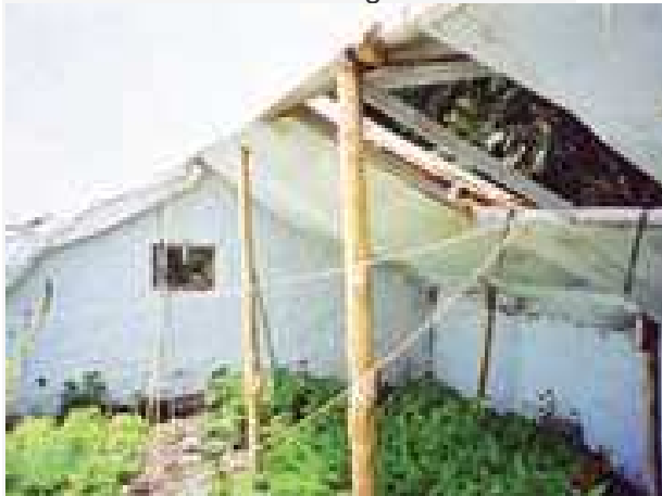
Figura 63: Un paño blanco añadido bajo el techo
