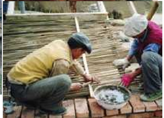
Figuras 65 y 66: Una estructura de techo de madera y bambú (Qinghai)
