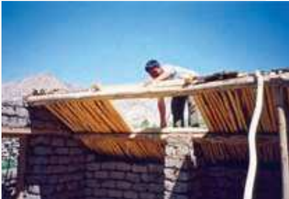
Figura 70. Fijar el marco del obturador del techo
