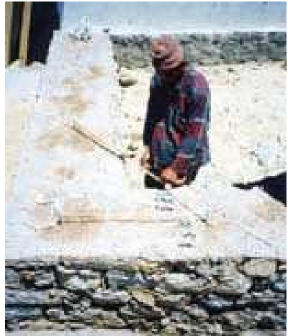
Figura 28: Dibujar un ángulo recto con el método '3,4,5 '
