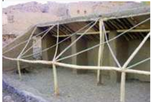
Figura 41: Acabado de las paredes de partición
