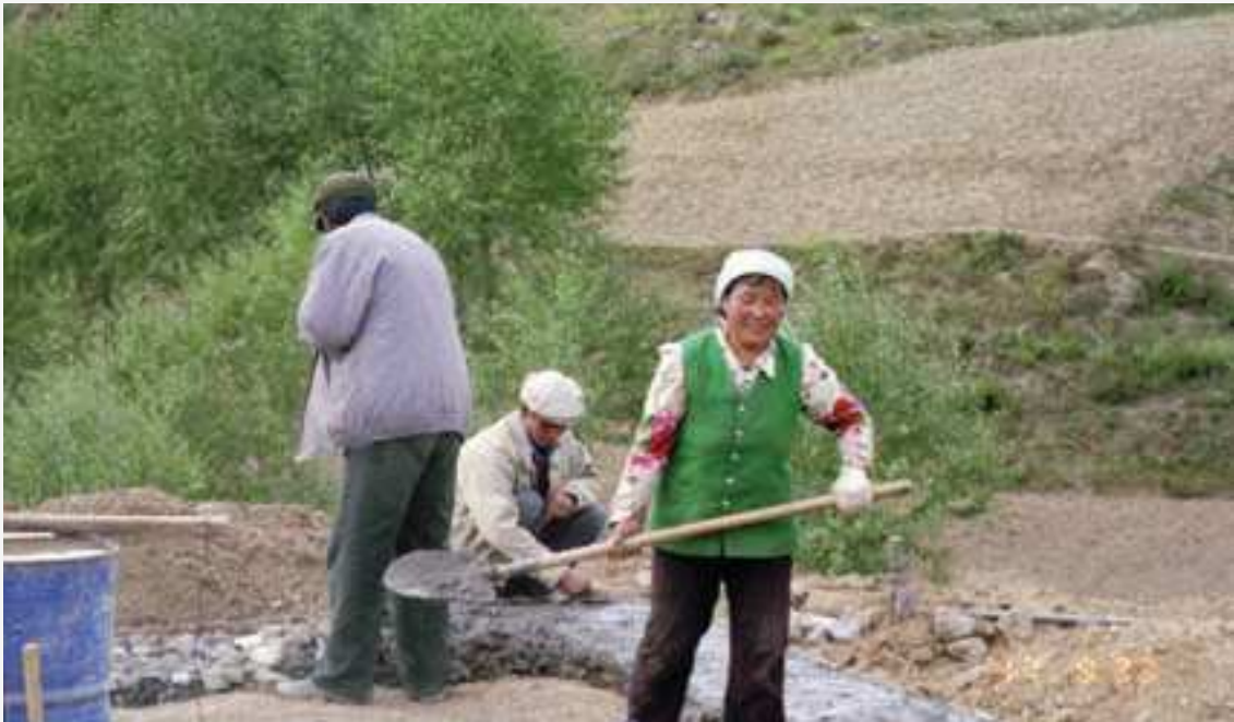
Figura 32.: Cubrir la parte superior de la base con una capa de hormigón Preparación del suelo del invernadero
