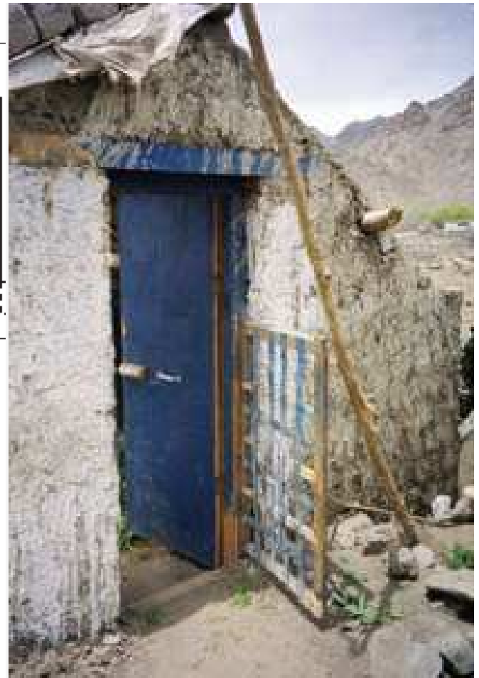
Figura 49: Un segundo obturador cubierto por bandas de metal
