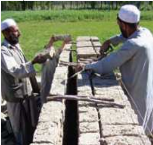
Figura 35: Plan de construcción de doble pared
