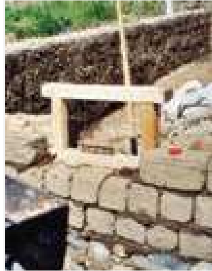
Figura 52: Colocación del marco del obturador en la pared
