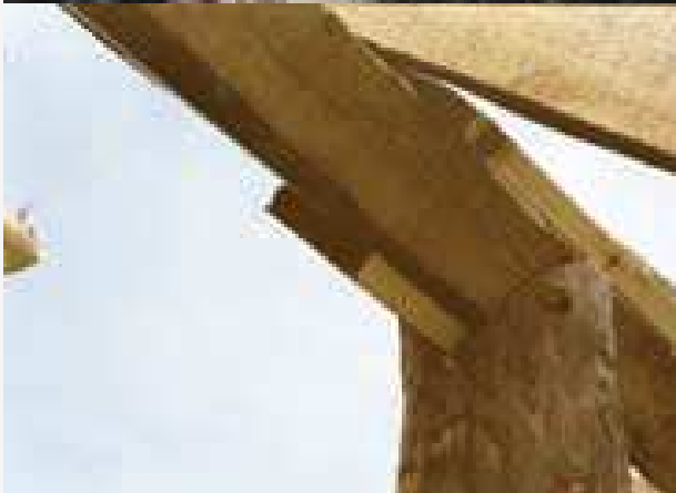
Figuras 56: La fijación de la viga a un poste, Ladakh (arriba) y Qinghai (abajo)
