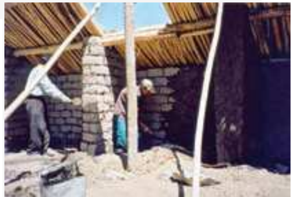
Figura 41: Acabado de las paredes de partición
