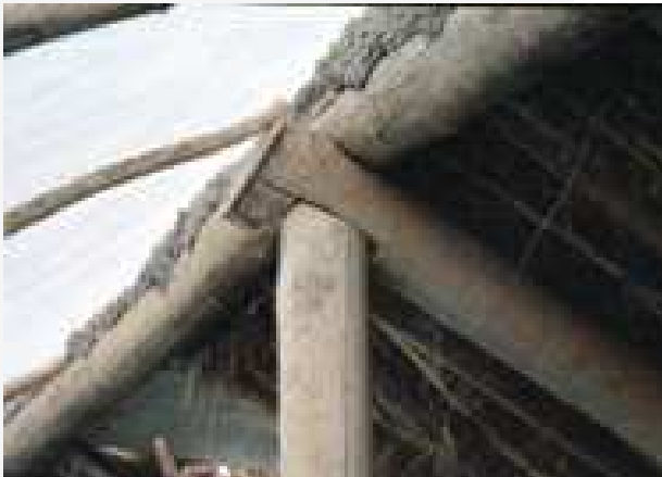
Figura 57: Techo de estructura con dos vigas y marcos del obturador en posición en Spiti
