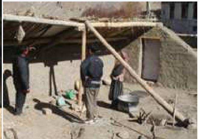
Figura 58: Viga Cruce hacia el sur
