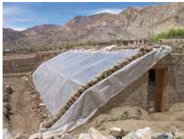
Figura 77. Vista general de fijar la hoja de polietileno
