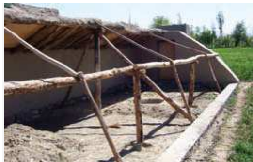
Figura 74: estructura de soporte de madera para la hoja de polietileno (Lowgar, Afganistán)
